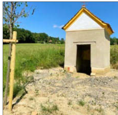
Die Pölzkapelle wurde generalsaniert
