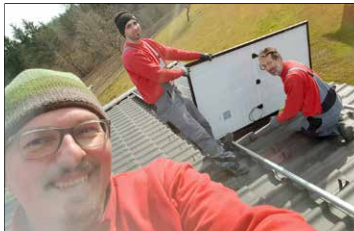
Photovoltaik-Montage in Glauning durch die Firma Elektro Hohl
