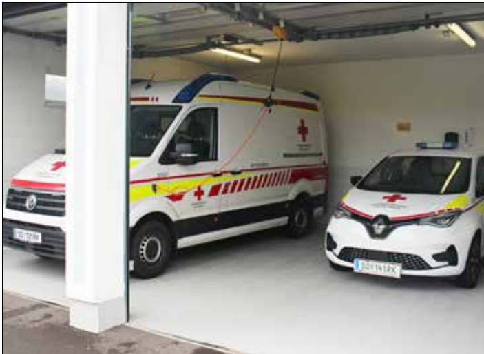
Renovierter Garagenboden bei der Ortsstelle St. Peter am Ottersbach
