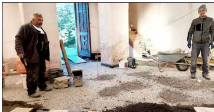
In der Kalvarienbergkirche wurde der Boden umfassend saniert
