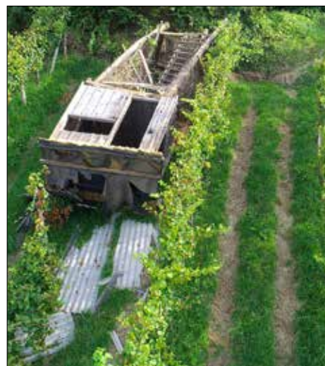
Totalschaden vom Hochsitz und Sprecherkabine
