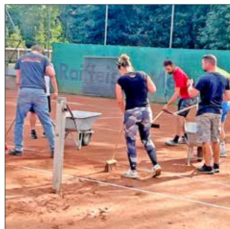
Die Platzsanierung nach dem Hochwasser
