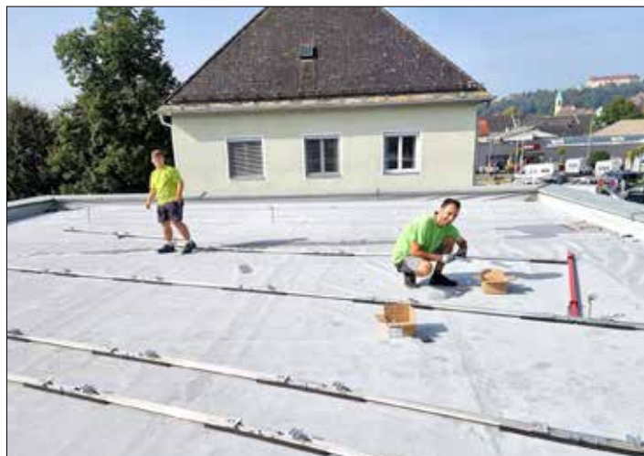
Montage einer Photovoltaik-Anlage bei der Arbeiterkammer in Leibnitz
