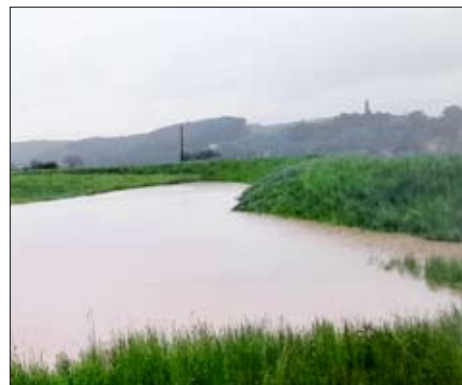
Rückhaltebecken in Perbersdorf bei St. Peter
