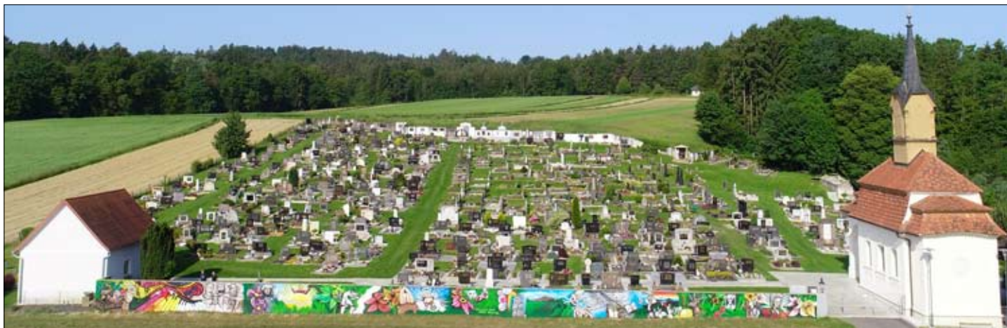
Trotz eines regenreichen Mai konnte die Friedhofsmauer früher als geplant fertig gestellt werden und erstrahlt in neuem Glanz
