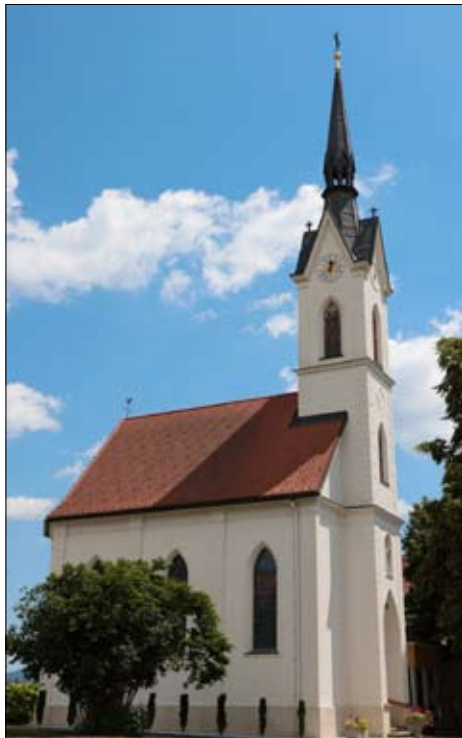
Die Dorfkirche wurde umfassend saniert
