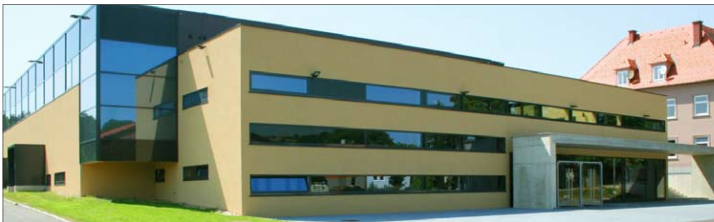
Die Ottersbachhalle hat sich seit der Errichtung im Jahr 2005 bei vielen Veranstaltungen gut etabliert und ist über die Gemeindegrenzen bekannt
