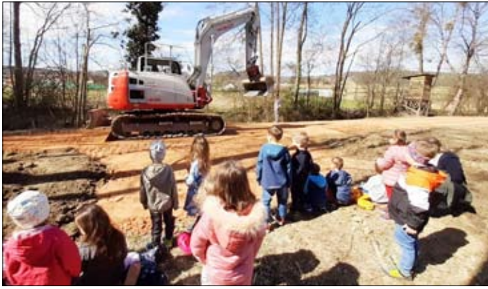
Aus dem Abbruchschutt der alten Volksschule wurde ein neuer Weg gemacht und wir durften dabei gespannt zusehen
