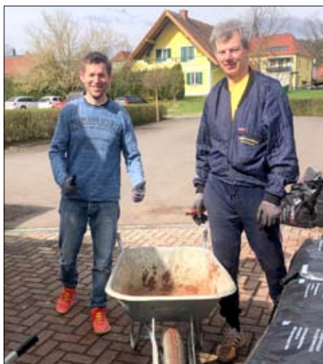
Einige Instandhaltungsarbeiten im Frühjahr
