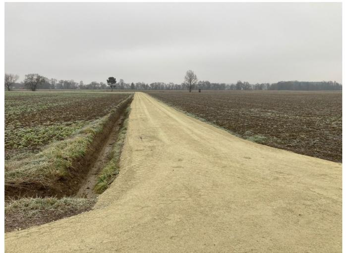
Aufgrund einer Förder- und Arbeitsvereinbarung zwischen dem Amt der Bgld. Landesregierung Abt. 5—Baudirektion und der Gemeinde Kohfidisch werden derzeit die Schäden im Bereich des landwirtschaftlichen Wegebbaus und der Gräben, die im Zuge des Hochwassers im Juni 2024 entstanden sind, saniert. Das Amt d. Bgld. Landesregierung übernimmt die Kosten der aufgenommenen Schäden in Höhe von rund € 76.500,—. Die Sanierungsarbeiten werden von den Mitarbeitern des Bauhofs organisiert.
