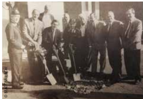
Bgm. Manzenreiter und Stadträte beim Spatenstich des Feuerwehrzentrums.
