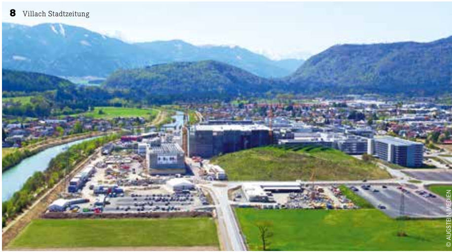
Blick über einen Teil der neuen Infineonstraße, die am 1. Mai eröffnet wird.
