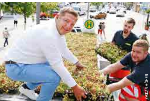
Bürgermeister Albel und Stadtgartenmitarbeiter beim Begrünen des Daches
