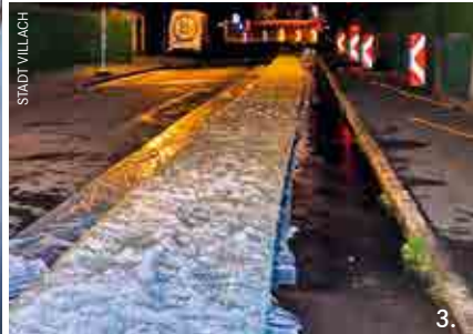
1. Heißer Wasserdampf steigt aus dem Kanal. Dieser bringt das Material in der sanierten Leitung zum Aushärten. 2. „Schlauchlining“ erspart Grabungsarbeiten und lange Verkehrsbehinderungen. 3. Der Schlauch wird gekühlt.
