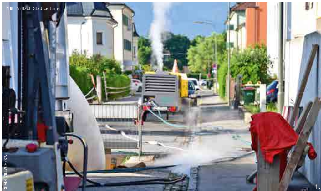
1. Heißer Wasserdampf steigt aus dem Kanal. Dieser bringt das Material in der sanierten Leitung zum Aushärten. 2. „Schlauchlining“ erspart Grabungsarbeiten und lange Verkehrsbehinderungen. 3. Der Schlauch wird gekühlt.
