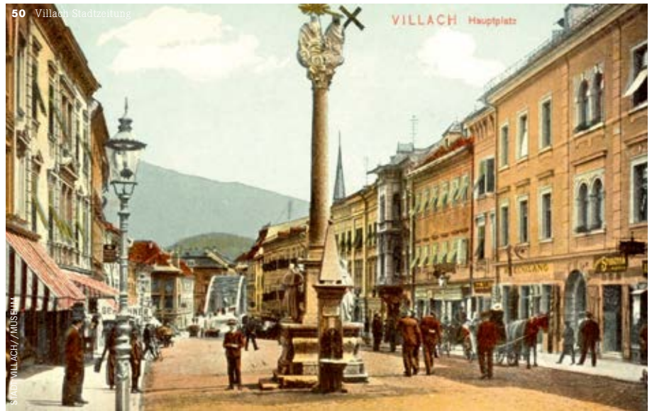
Die Dreifaltigkeitssäule, hier auf einem Bild um 1905, hat seit ihrer Fertigstellung im Jahr 1739 bereits mehrmals ihren Standort gewechselt.
