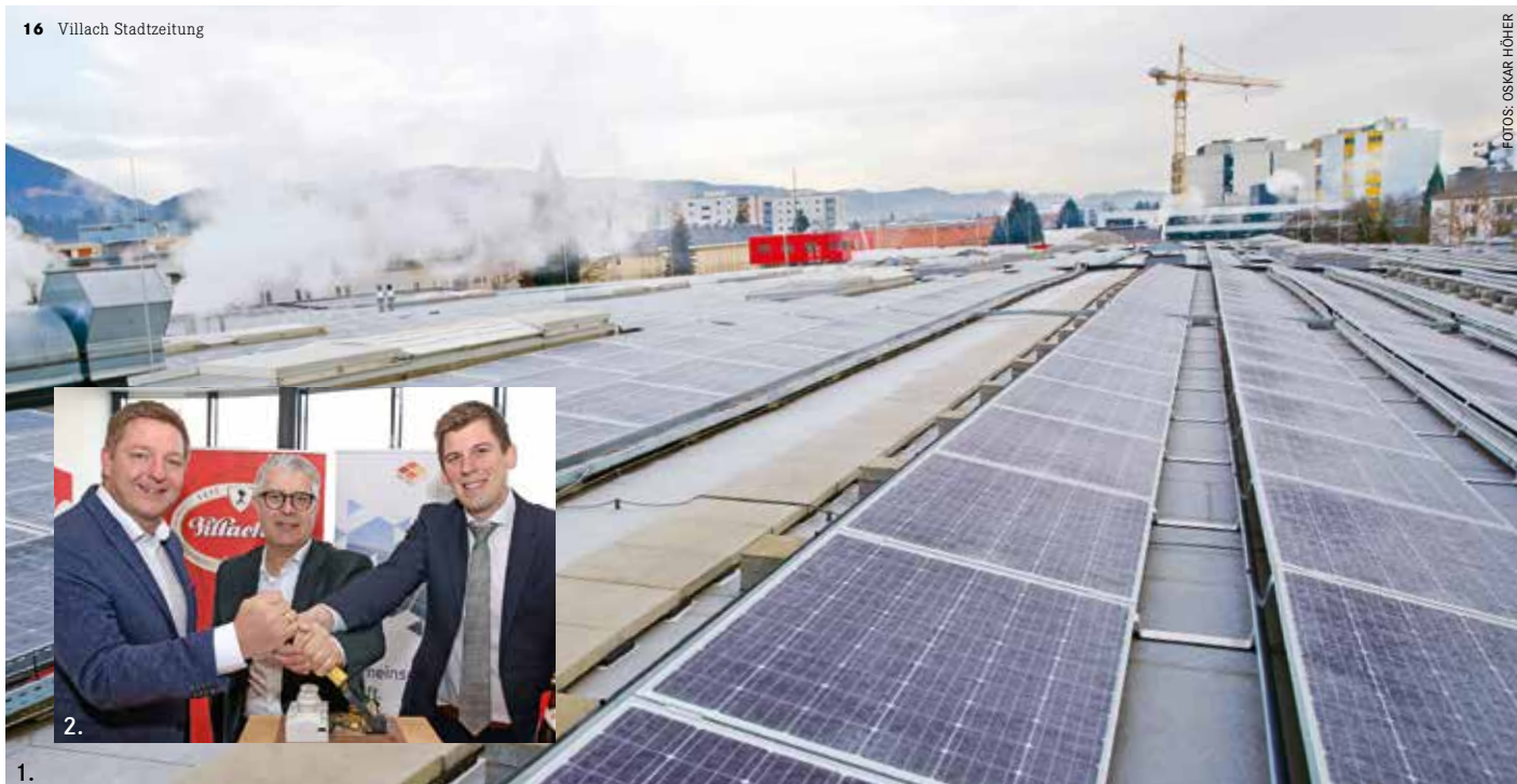
1. Blick über die neue PV-Anlage der Villacher Brauerei. 2. Von links Bürgermeister Günther Albel, Brauerei-Vorstand Thomas Santler und Matthias Nadrag von WIR Energie.
