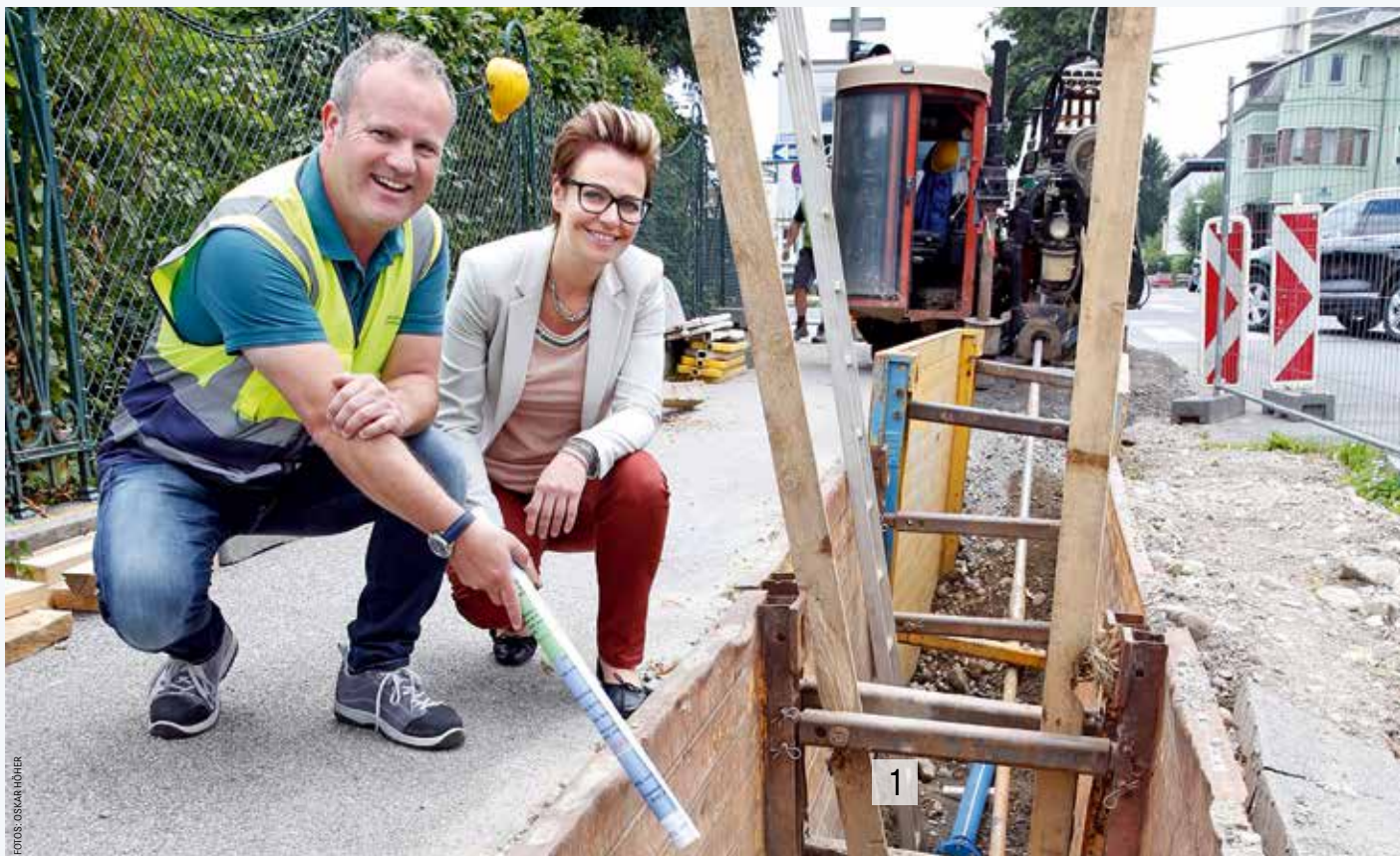
Stadträtin Katharina Spanring mit Wasserwerksmitarbeiter Arthur Lippitsch begutachten das Horizontalspülverfahren in der Pestalozzistraße.
