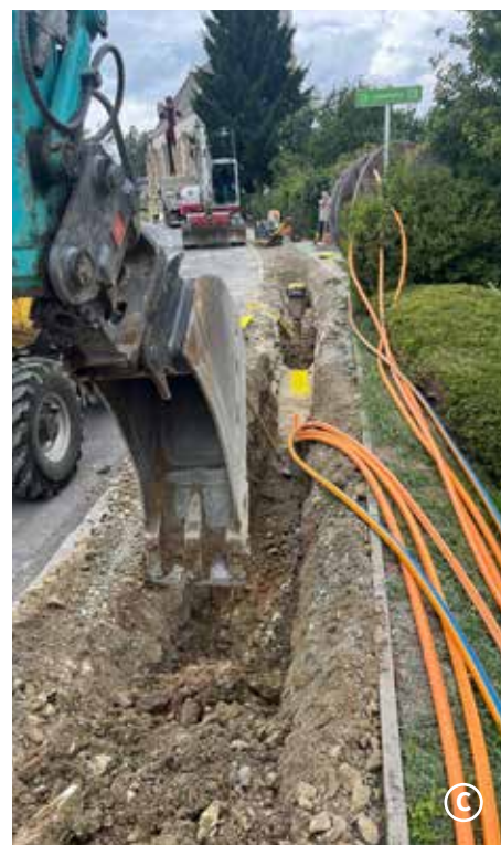
Beim Streetsoccerplatz wurde ein neuer Belag verlegt und die Zaunanlage erhöht (A). Aufgrund der im kommenden Jahr geplanten Sanierung der Landesstraße ist auch die Ortswasserleitung erneuert worden (B). Aus dem gleichen Grund wurde auch das Glasfaserkabel verlegt (C).
