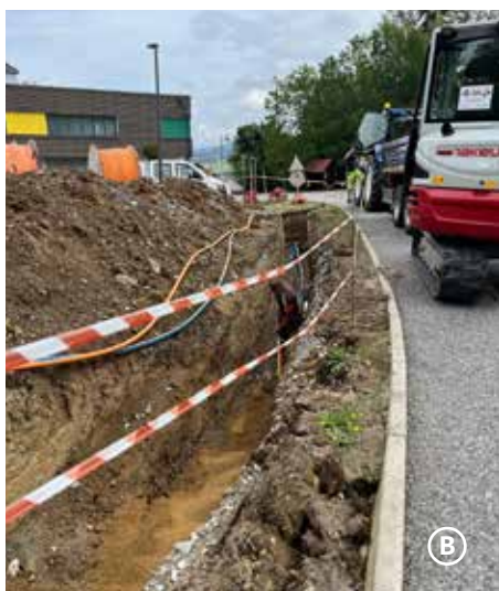
Beim Streetsoccerplatz wurde ein neuer Belag verlegt und die Zaunanlage erhöht (A). Aufgrund der im kommenden Jahr geplanten Sanierung der Landesstraße ist auch die Ortswasserleitung erneuert worden (B). Aus dem gleichen Grund wurde auch das Glasfaserkabel verlegt (C).
