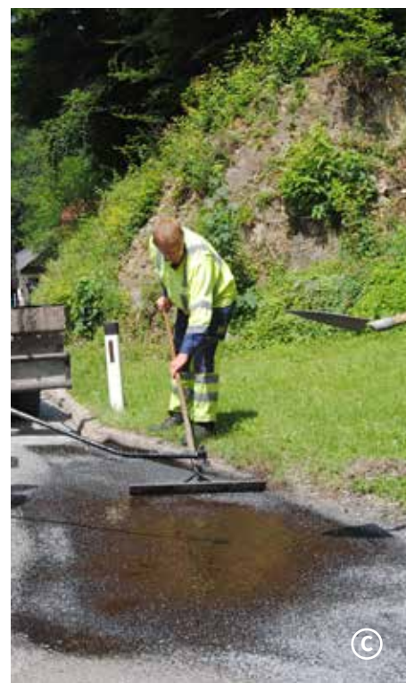
Belagsarbeiten an der Einmündung des Brunnleitenweges in die Landesstraße L336 (A). Immer unermüdlich im Einsatz: Unser Bauhofleiter Erwin Kröll (B). Kleine Reparaturen an den Fahrbahnrandern verhindern, dass größere Schäden entstehen, deren Behebung dann ein Vielfaches kostet (C).
