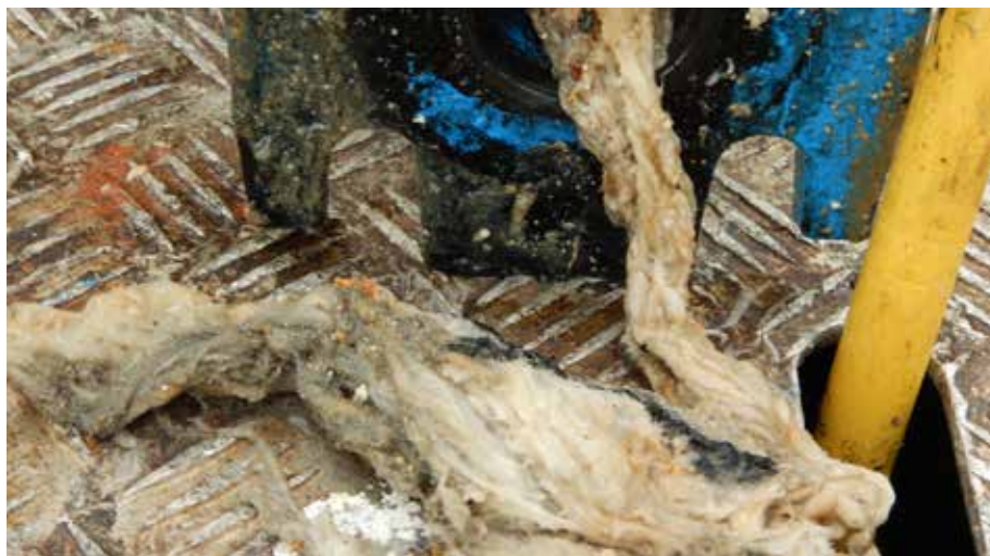
Hier erkennt man deutlich, wie sich die im Kanal entsorgten Feuchttücher zu einem „Zopf“ verbunden haben, der sich wie eine Schlange um das Laufrad der Pumpe wickelt.
