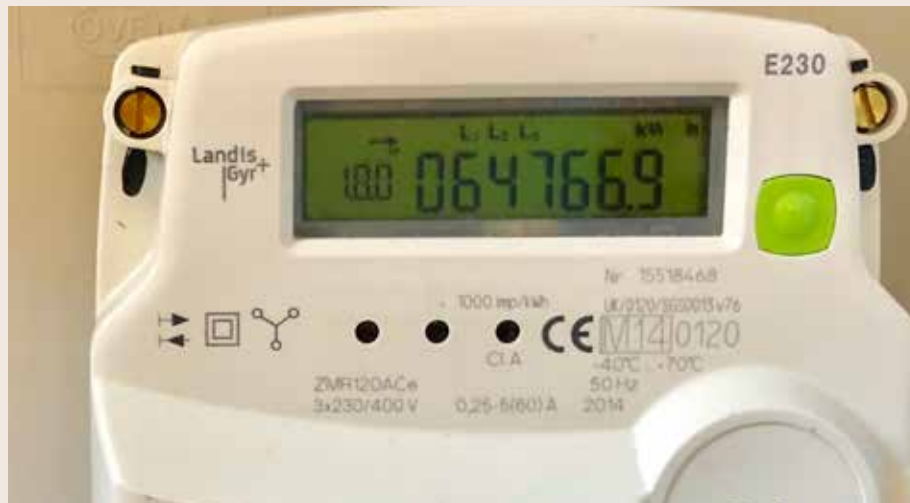
Alte Stromzähler werden nach der Errichtung und Fertigstellung der Photovoltaik-Anlage gegen neue digitale Geräte ausgetauscht.
