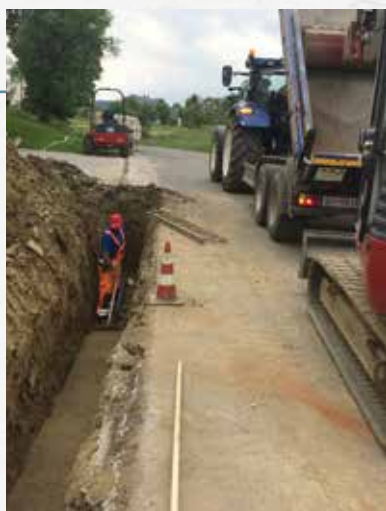
Herstellung der normgerechten Bettung der neuen Wasserleitung
