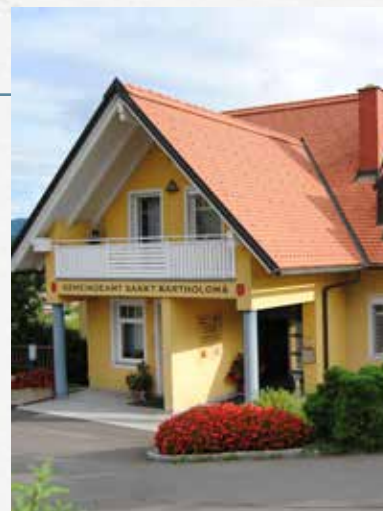
Vor dem Eingang sind Sanierungsarbeiten durchzuführen.
