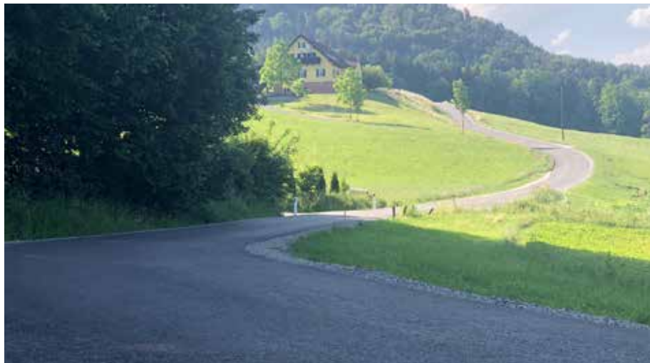
Mittlerweile ist der Strimbauerweg mit einer neuen Asphaltdecke versehen. Auch die Bankettarbeiten sind abgeschlossen.
