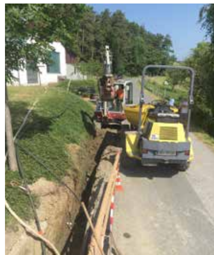
Beim letzten Bauabschnitt wird derzeit die Ortswasserleitung neu verlegt.
