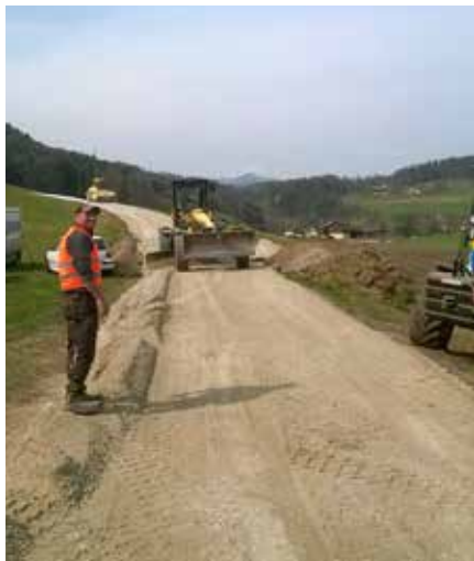
Im Frühjahr dieses Jahres wurde die Tragschicht beim Strimbauerweg verstärkt.
