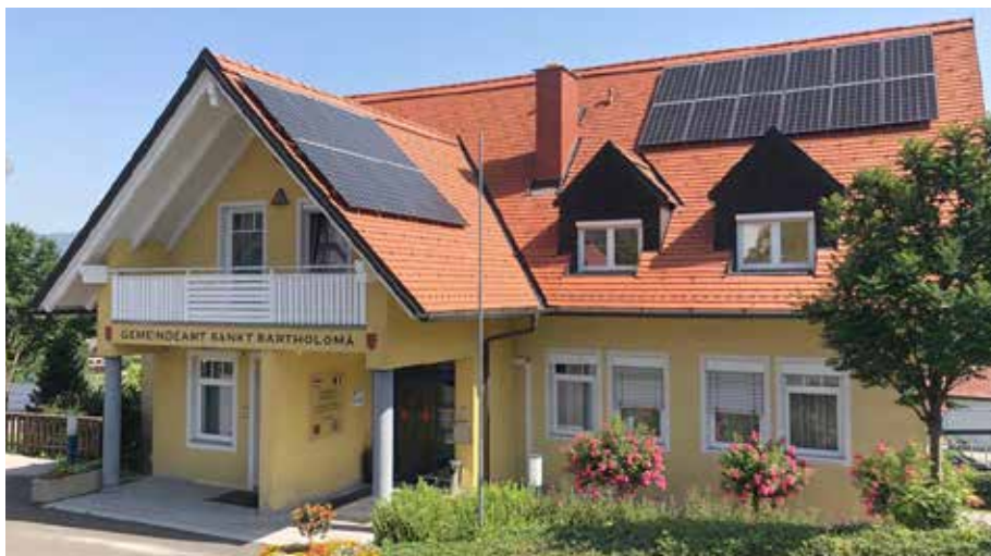
Unser Amtsgebäude wurde mit einer Photovoltaikanlage ausgestattet. Insgesamt 20 Solarmodule helfen uns die Sonnenenergie zu nutzen.
