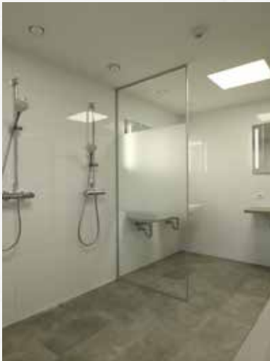
Die Sanitärräume wurden großteils von ortsansässigen Firmen saniert.
