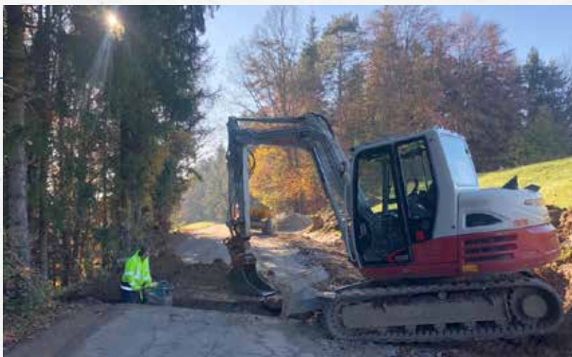
Die Grabarbeiten für die Verlegung der Durchlässe hat die Firma Schober aus Lichtenegg durchgeführt.
