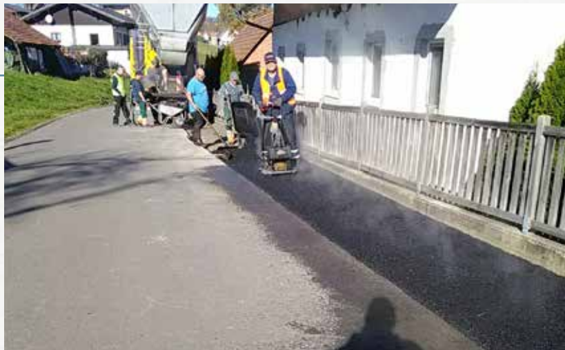
Beim Michelbachweg wurde vor dem Wohnhaus in St. Bartholomä 47 (Familie Summer) eine Kleinfläche neu asphaltiert.
