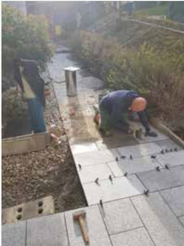
Vor dem Gemeindeamt waren auch Pflasterungsarbeiten notwendig.
