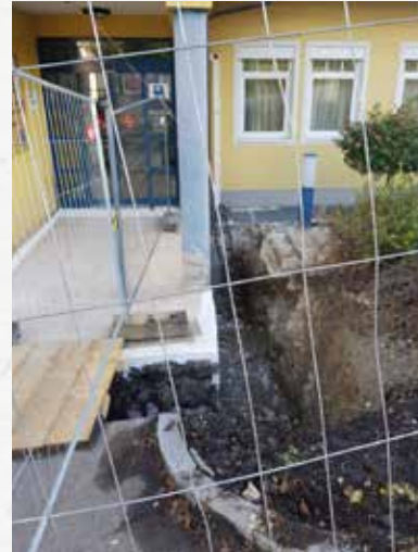
Aufgrund des Feuchteschadens musste tief gegraben werden.
