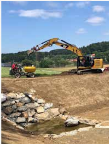
Die Firma Essich aus Gössendorf führte die Baumeisterarbeiten durch.
