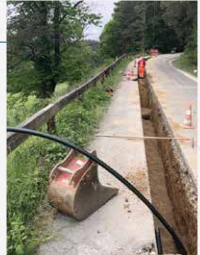
In einer Tiefe von rund 1,6 Meter wird die Wasserleitung neu verlegt.
