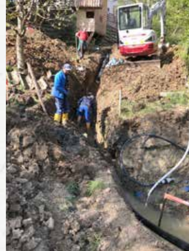
In einem Teilbereich wurde auch die Wasserleitung neu verlegt.
