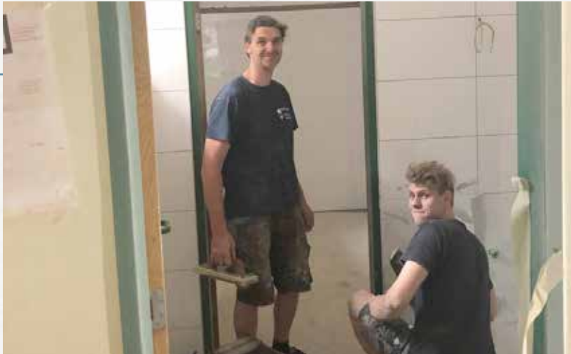
Firmenchef Hannes Offenbacher und sein Sohn Manuel aus Jaritzberg sind mit den Fliesenlegerarbeiten beschäftigt.
