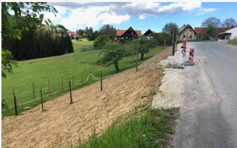
Bei der Reitereggerstraße gegenüber der Firma Payer wurde die Rutschung fachgerecht und professionell saniert.
