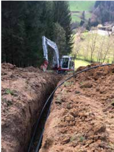
Auch eine Leerverrohrung für schnelleres Internet wurde mitverlegt.
