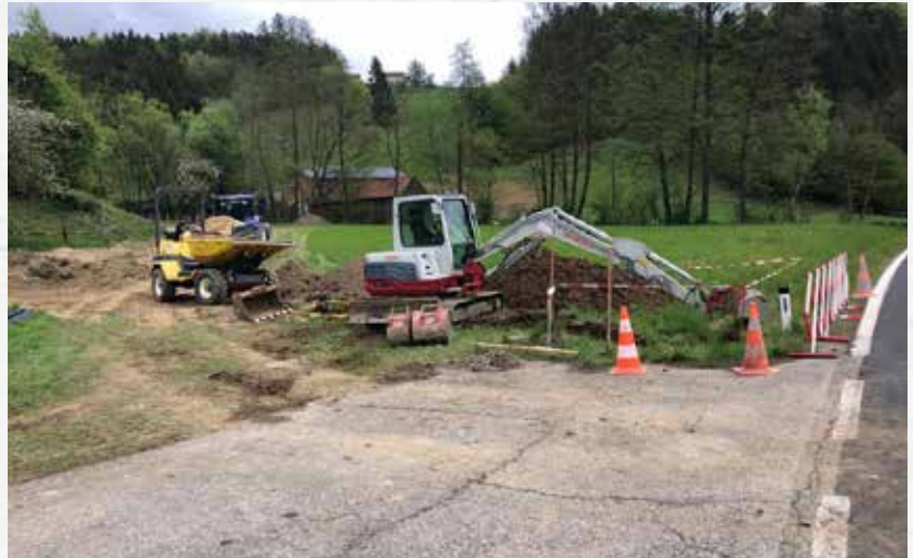
Die Ortswasserleitung musste auch unter die Landesstraße 336 in Richtung Stiwoß verlegt werden.
