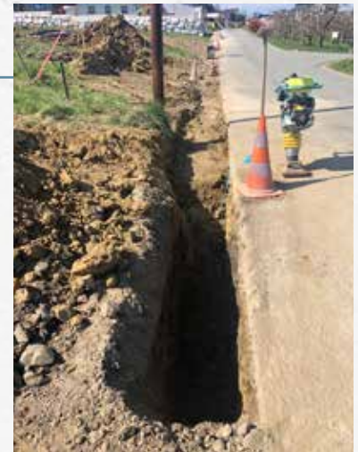
Die neue Wasserleitung wurde unmittelbar neben der Straße verlegt.
