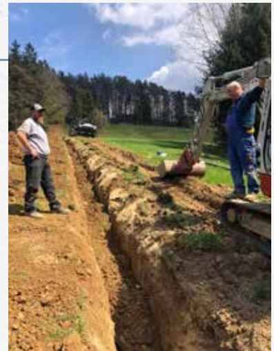
Wassermeister Gutjahr und ein Mitarbeiter der Fa. Schober bei der Arbeit.
