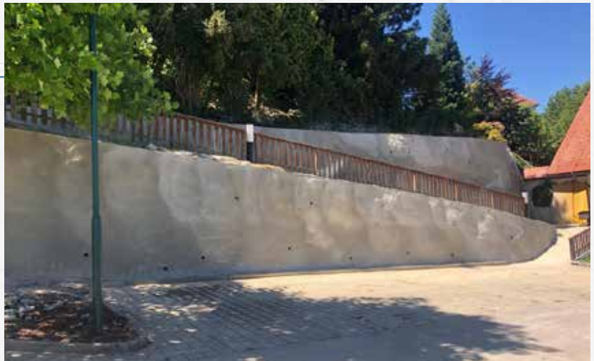
Die Stabilisierung der Steinmauer mit Spritzbeton wurde zu unserer vollsten Zufriedenheit erledigt.
