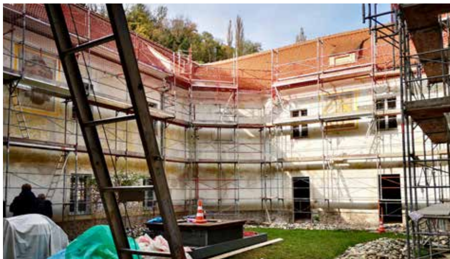
Um vier Millionen Euro wurde das 1913 eröffnete Steirische Volkskundemuseum, ein ehemaliges Kapuziner-Kloster, während der Pandemie umfassend saniert und umgebaut.
