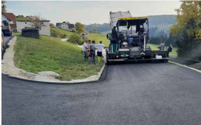
Dieses Bild zeigt die große Asphaltiermaschine beim Kulmerbauerweg im Zufahrtsbereich zur Familie Hösele vlg. Simabauer.
