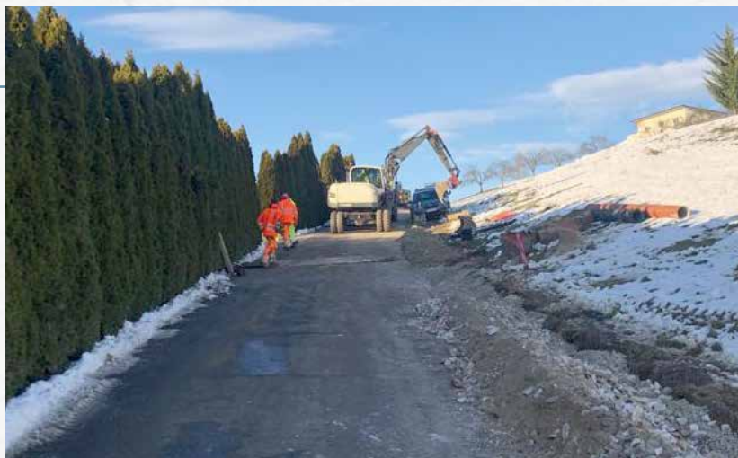
Die Entwässerungsarbeiten entlang des Kulmerbauerweges sind in vollem Gange.
