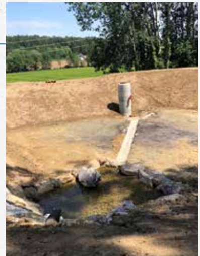
Mittlerweile wurde das Retentionsbecken fertiggestellt.
