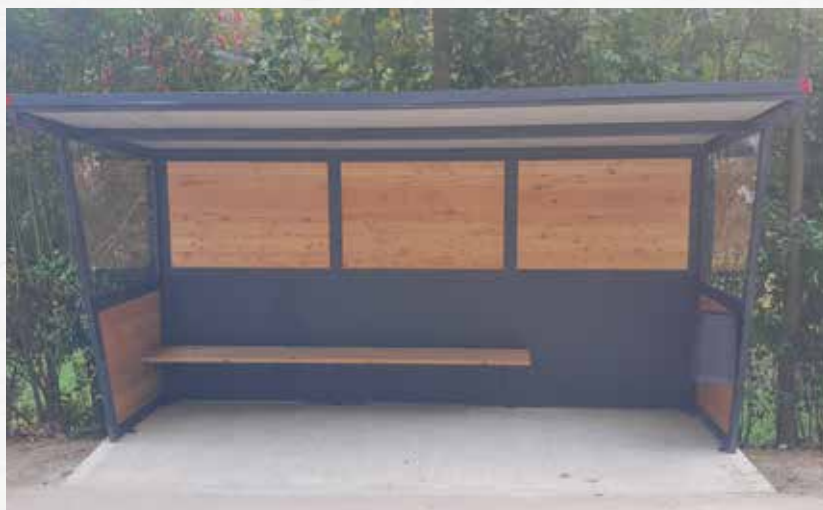
Das sanierte Buswartehäuschen schützt die Fahrgäste des öffentlichen Verkehrs vor Wind und Regen.
