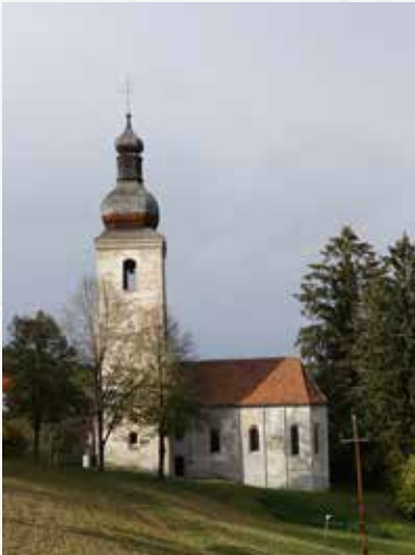
Die Fassadensanierung wird im Frühjahr 2023 durchgeführt.
