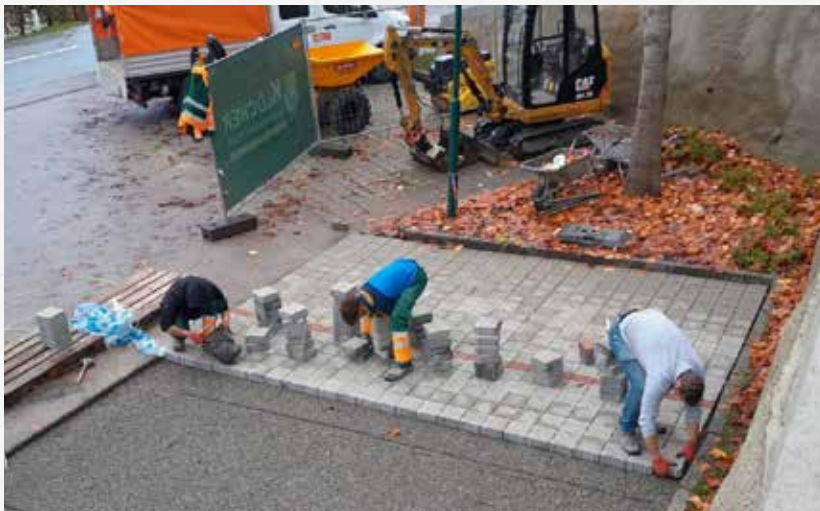
Die Firma Klöcher-Bau wurde für diese Bauarbeiten herangezogen und hat dieses Vorhaben zur vollsten Zufriedenheit ausgeführt.
