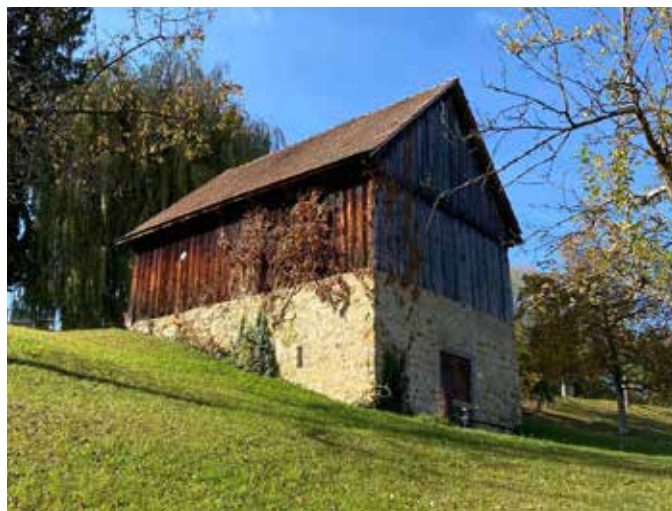
Mit der Sanierung wird das Kellerstöckl nutzbar gemacht, äußerlich bleibt es nahezu unverändert.
