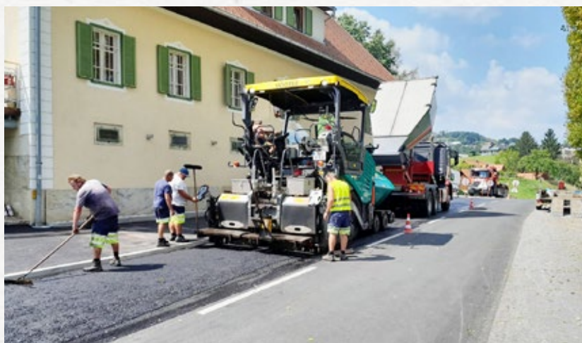
Im Bereich vom Buschenschank Dorner wurde der Gehsteig saniert, auch die Ortswasserleitung wurde in diesem Abschnitt erneuert.
