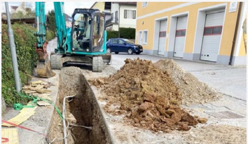
Die Baumeisterarbeiten für die Ortswasserleitung wurden von der Firma PORR durchgeführt.
