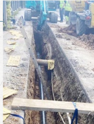
Der Wasserleitungsausbau am Oswaldeckweg ist fast abgeschlossen.
