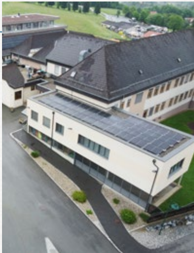
Die im März beschlossene PV-Anlage steht kurz vor der Fertigstellung.
