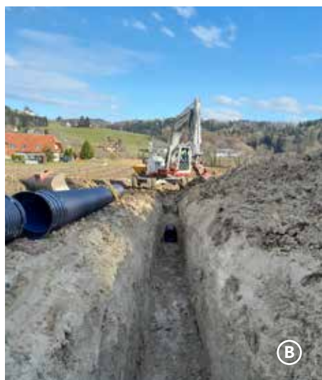
Die Umbauarbeiten der Volksschule sind im vollen Gange (A). Für die neue Wohnanlage in der Lichteneggstraße wird für die Oberflächenentwässerung ein Regenwasserkanal benötigt (B). Der erste Bauabschnitt mit insgesamt 12 Wohneinheiten nimmt immer mehr Gestalt an (C).
