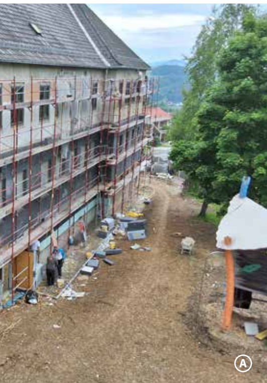
Auch die Außenfassade unserer Volksschule wird gedämmt und saniert und befindet sich derzeit im Bau (A). Der Zwiebelturm der Alten Kirche wird neu eingedeckt und daher demoniert (B). Der 22-jährige Maximilian Gutjahr aus Jaritzberg verstärkt seit einigen Wochen das Bauhofteam (C).
