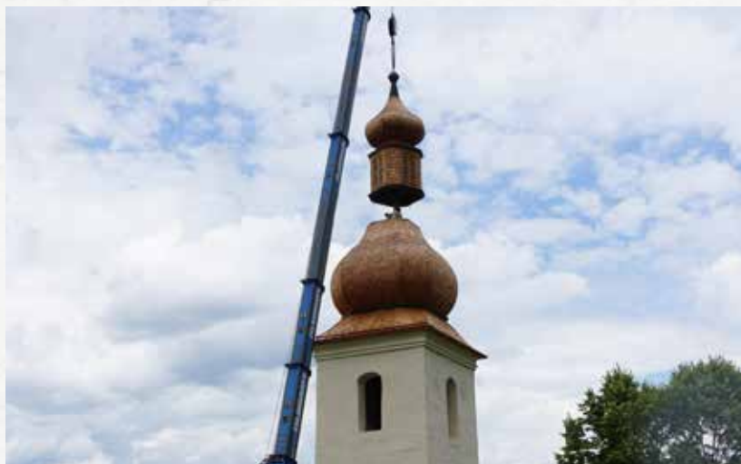
Mittels Kran wurde der neueingedeckte Zwiebelturm wieder an seinem ursprünglichen Platz gebracht.
