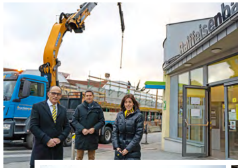
Lokalausweis: Bgm. Mag. Rainer Porics, Regionalleiterin Mag. Christina Locsmandy und Bankstellenleiter Robert Klikovits überzeugten sich vom Baufortschritt
