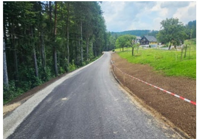
Unsere Gemeindestraßen werden laufen saniert.
