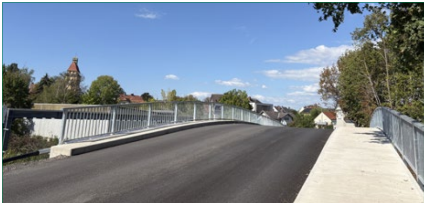
Die Eselsbrücke in der Mühlbreitenstraße als Bindeglied zwischen dem Stadtteil und dem Stadtzentrum wurde ab dem Frühjahr grundlegend saniert und Mitte August asphaltiert.
