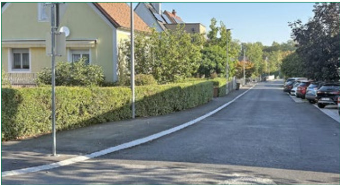
Die Fahrbahn in der Mozartstraße direkt beim Kreisverkehr am Stadtbergenweg nahe der Pflanzenwelt Langer wurde ebenfalls heuer erneuert.
