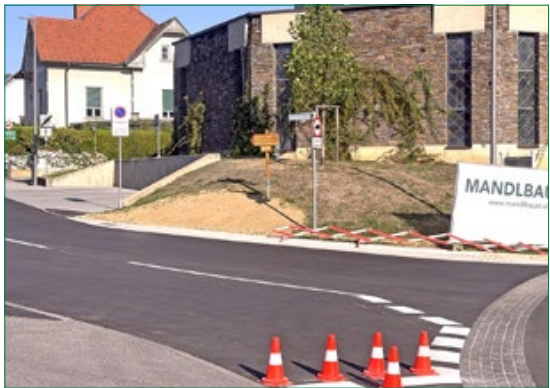
Die Einfahrt von der Kusmanek- in die Buchwaldstraße bei der Bestattung Urschler und beim katholischen Friedhof konnte mittlerweile ebenfalls fertiggestellt werden.
