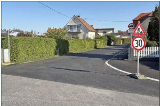
Das Baustellenschild an der Kreuzung Stadtbergenweg/Hölderlinstraße kann nun nach Bauende abmontiert werden.
