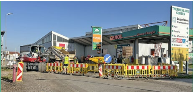
Von Mitte Juli bis Jahresende 2026 werden umfassende Baumaßnahmen im Bereich der Fürstenfelder Jahnstraße umgesetzt, aktuell laufen die Bauarbeiten bereits auf Hochtouren.
