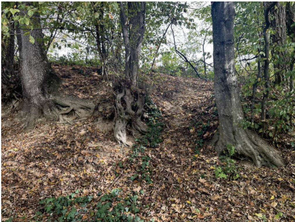
Foto 6: Ostseitige Einschnitt Böschung des Verbindungsweges im Bereich des geplanten Anschlusses der Erschließungsstraße
