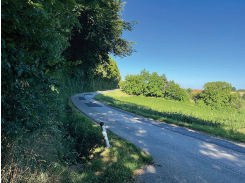
„Neuer Kreuzungsbereich“ Hofberg Weg Blickrichtung Osten | Quelle: Nussmüller Architekten
