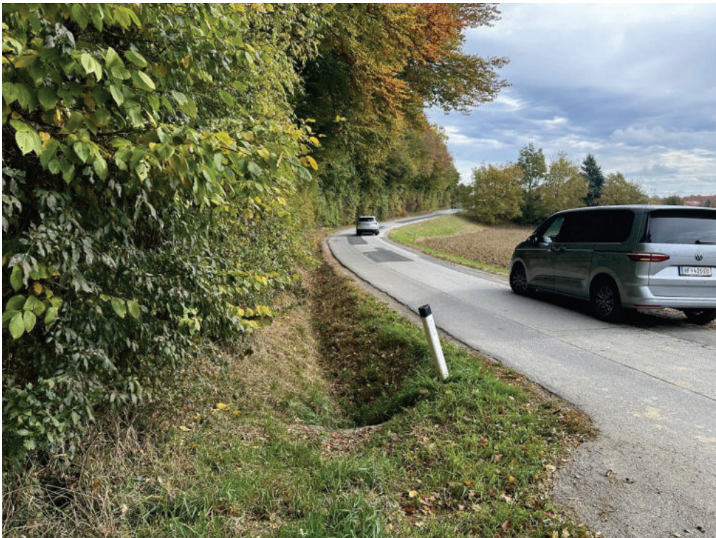
Foto 2: Bestehende Anbindung des Verbindungsweges an den Hofbergweg Blickrichtung Ost
