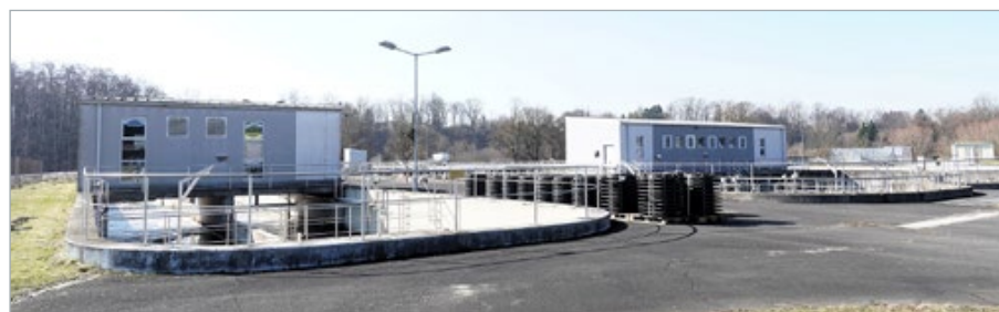
Die Verbandskläranlage des Abwasserverbands Fürstenfeld, die im Jahr 1997 in Betrieb genommen wurde, muss in den nächsten Jahren nach gesetzlichen Richtlinien auf neuesten Stand der Technik gebracht werden. Dabei müssen auch steigende Einwohnerzahlen sowie die Möglichkeit der Rückgewinnung seltener Rohstoffe berücksichtigt werden.
