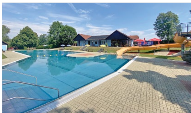
Vor der Eröffnung am 29. Mai erfolgt im Söchauer Freibad eine grundlegende Neugestaltung des Außenbereichs mit neuer Zaunanlage und neuen Parkplätzen an der Zufahrtsstraße.
