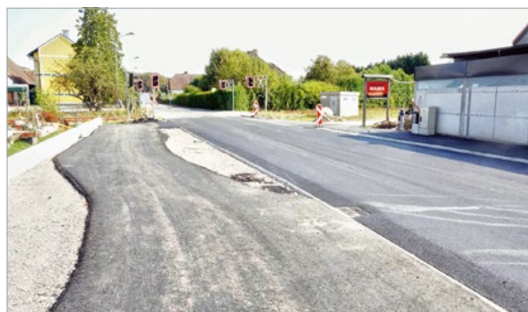
Die Baumaßnahmen im Bereich der Fehring- und Loipersdorfer Straße wurden über den Sommer durchgeführt, bis Ende September erfolgen noch die abschließenden Feinarbeiten.
