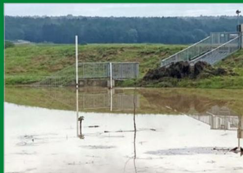
Die Errichtung des Hochwasserschutzes in Altenmarkt mit dem Retentionsbecken bewahrte den Ortsteil nach August 2023 bereits zum zweiten Mal vor einer massiven großflächigen Überschwemmung.
