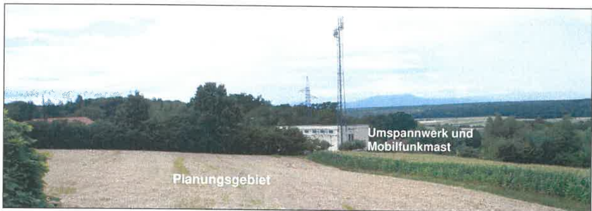
Blick nach Westen: Umspannwerk (110kV-20kV) und Mobilfunksender nord-westlich des Planungsareals
