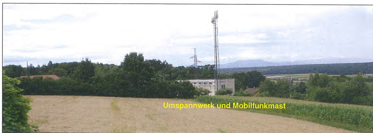
Blick nach Westen: Umspannwerk (100kV-20kV) und Mobilfunksender westlich des Planungsareals
