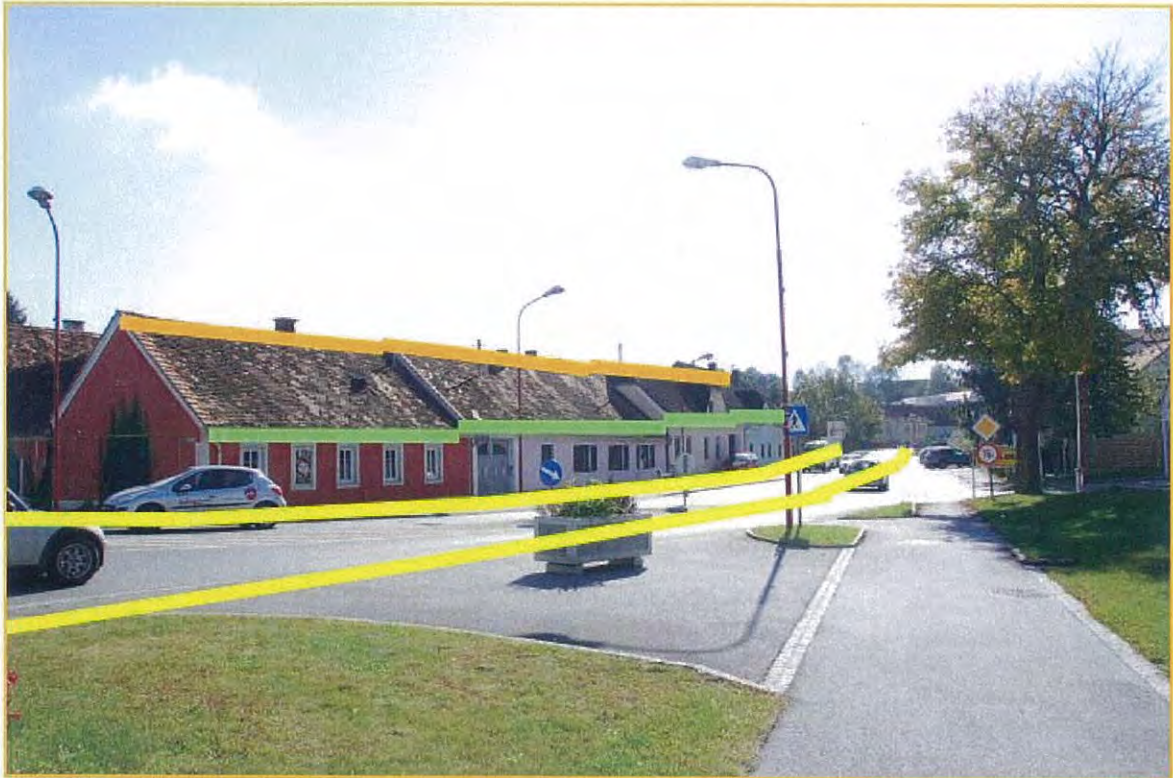
Bild 7: Stadteinfahrt, Straßenverlauf, Gebäudehöhen, Traufen und Straßenfluchten der Gebäude
