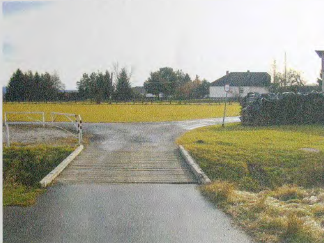
Abb. 3: Blick von der Landesstraße L401 über die Brücke Katzbach in Richtung Osten auf das Planungsgebiet.
