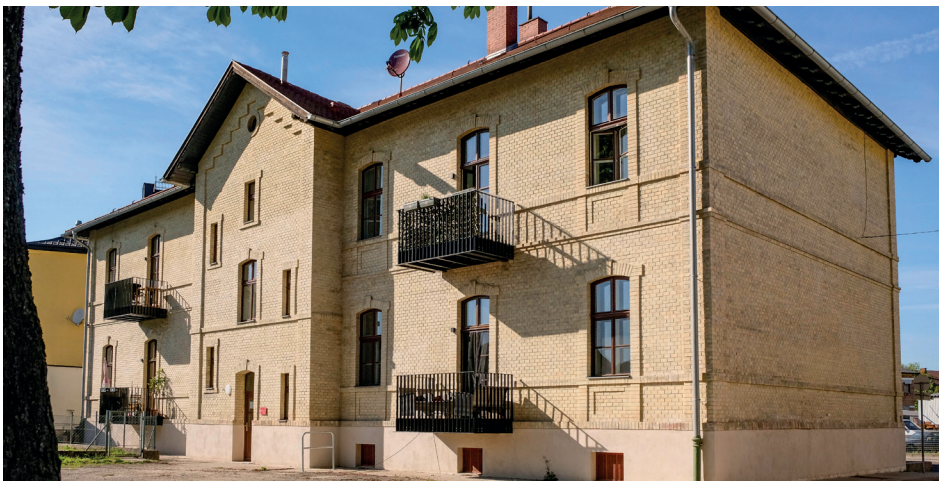
Das Gebäude bei der Parndorferstraße ist fertig. Im Bereich Kiralystraße und Heizhausgasse werden die historischen Gebäude von der ÖBB und der OSG saniert.
