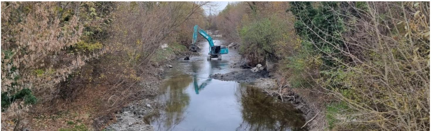
**Spezialbagger beim Bau einer Buhne in Höhe des Fischereivereinshauses**
