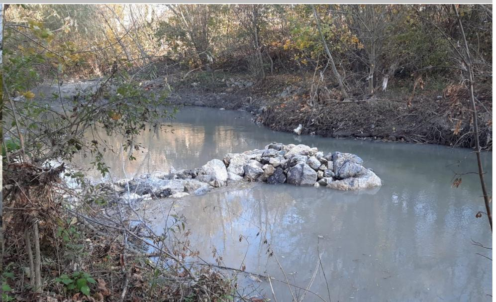
**Eine fertig gestellte Buhne bei der Eisenbahnbrücke, man erkennt gut, dass die Fische mühelos und ohne Probleme die Leitha flussaufwärts zum Ablachen schwimmen können!**
