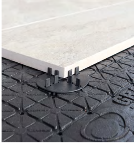
Verlegung der Platten mit Fugenkreuzen
