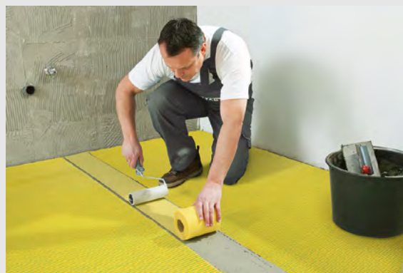
Dichtband 30 lfm/Rolle, B=15 cm
