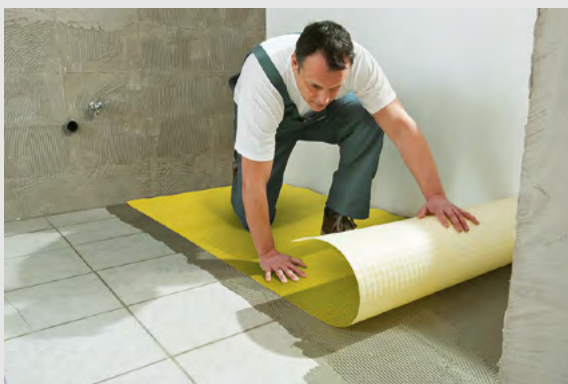
Verlegung über alten Bestand: Fliesen, Holz, Beton
