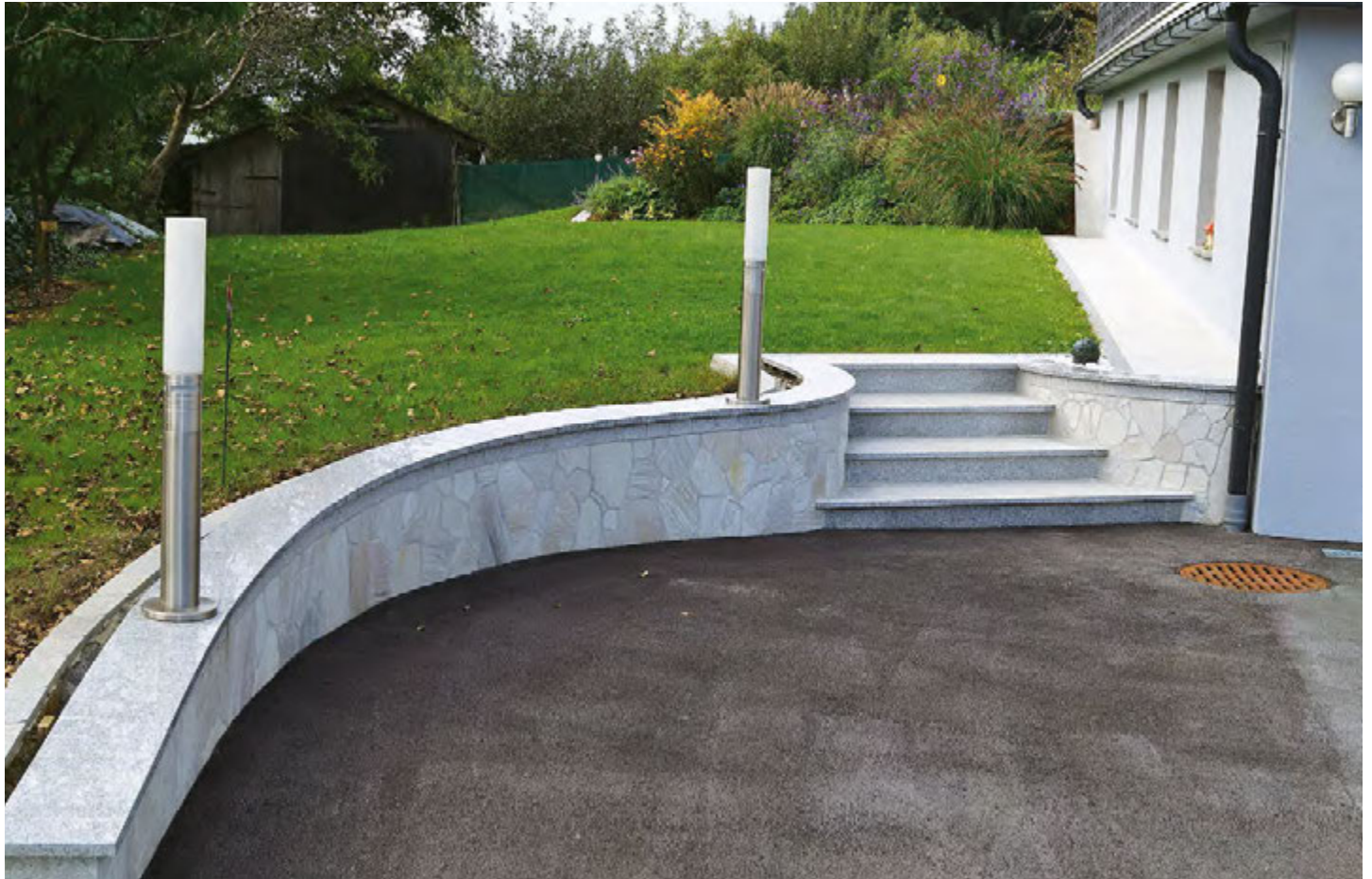
Ausführung: 2 Kanten gefast und poliert, zwei Wassernasen
