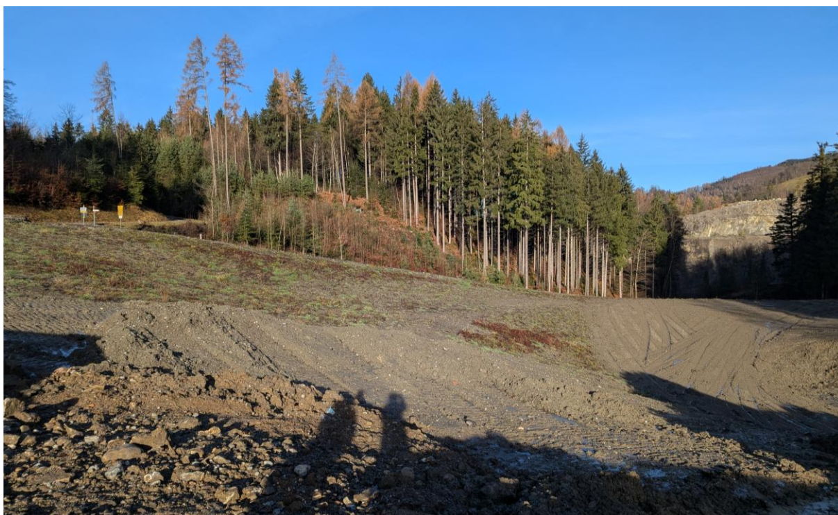
Bereich bestehende und neu eingerichtete Bodenaushubdeponie (Blickrichtung Nordwest)
