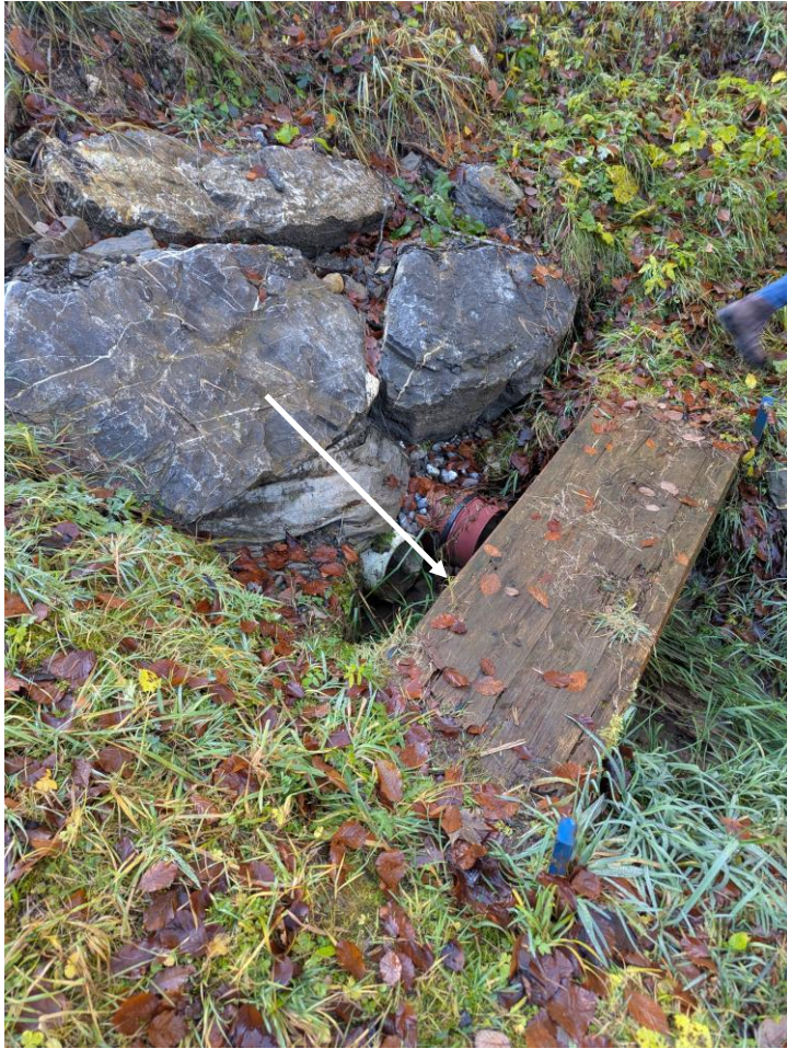
Messstelle Schacht 2 – Messstelle Wasser
