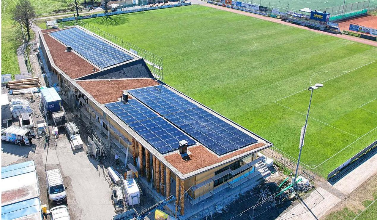
**Auf dem Dach wurde eine leistungsstarke Photovoltaikanlage installiert.**
