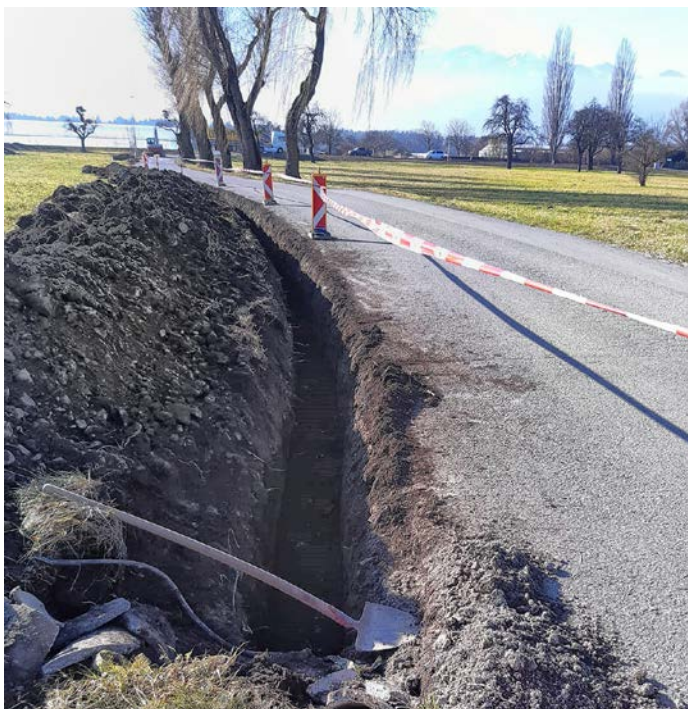
Der Kreuzungsbereich Landesstraße L63, Sickler und Haltestelleweg wird neu gestaltet.
