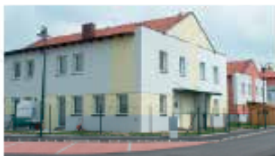
Viertelhäuser in Mannersdorf/L.
