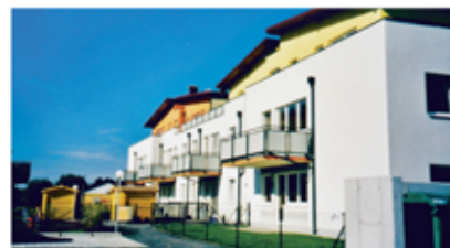
Wohnhausanlage in St. Pölten-Hart
